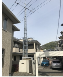
タワーを縮めて 撮影 高さ25mまで上げて運用、360度 回転可能
