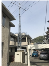
タワーを縮めて 撮影 高さ25mまで上げて運用、360度 回転可能。地球上 全域カバーします。
