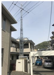
タワーを縮めて 撮影 高さ25mまで上げて運用、360度 回転可能。地球上の全域をカバーして交信します。
