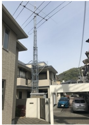
タワーを縮めて 撮影 高さ25mまで上げて運用、360度 回転可能。地球上の全域をカバーして交信します。
